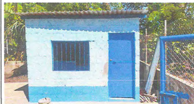
Foto 5: puerta de cocina
