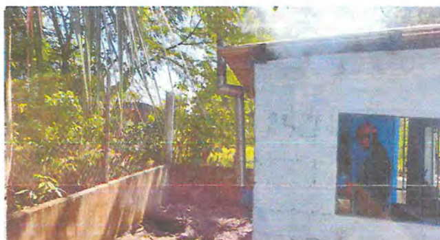
Foto 6: chimenea de cocina
