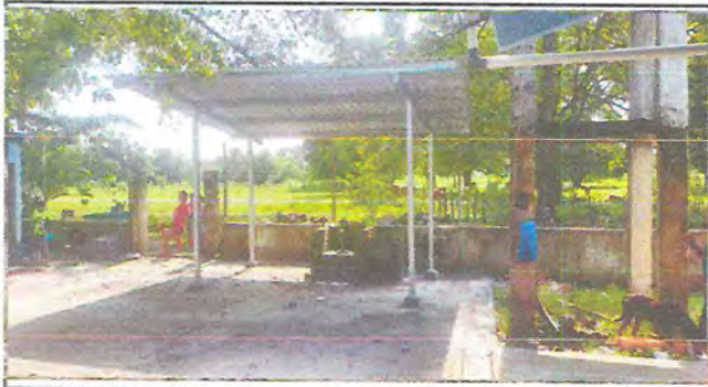
Foto 7: Estructura y techo de galera
